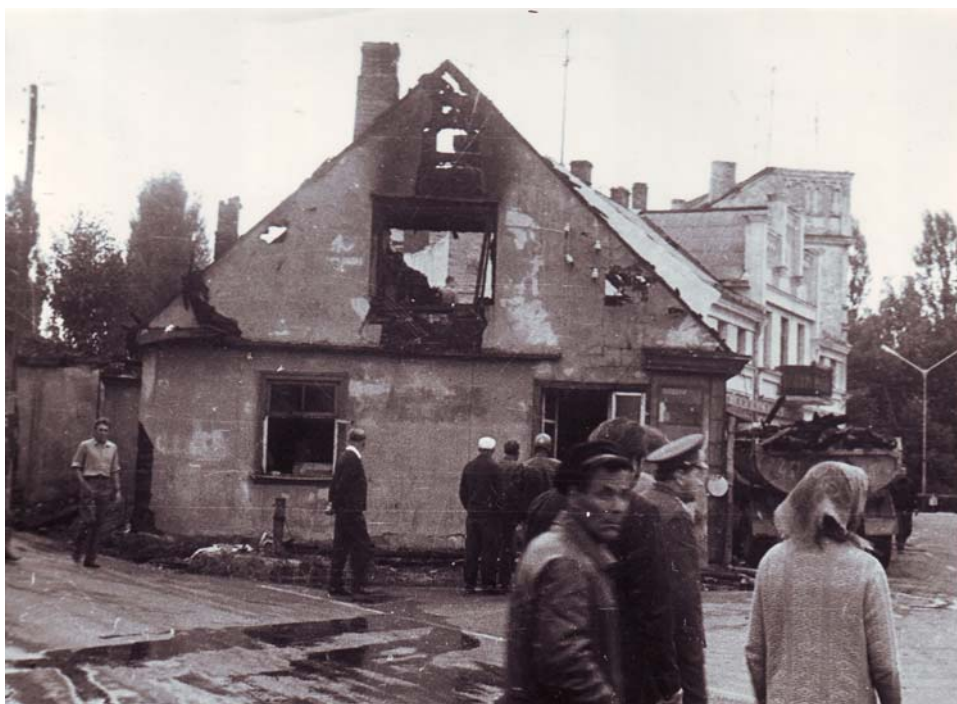
Pēc ugunsgrēka 14.08.1975. Tukums, Sarkanarmijas iela 15. (Fotogrāfija no S.Peipiņa privātā arhīva)
